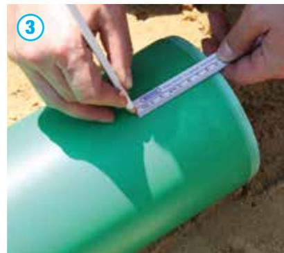
Глубина вставки гладкого конца в раструб должна быть измерена с помощью рулетки и отмечена маркером на гладком конце трубы. Таким образом будет возможно проконтролировать правильность установки изделий относительно друг друга.
