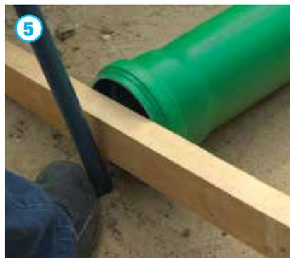
Трубы малого диаметра могут быть соединены вручную; для больших диаметров может потребоваться дополнительное оборудование. Соединение с помощью ковша экскаватора запрещено из-за плохо контролируемой мощности оборудования и возможности повреждения трубопровода.
