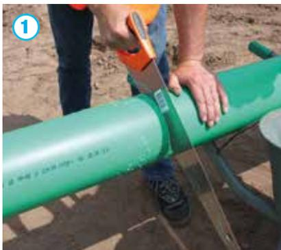
Укладка системы KG 2000 должна осуществляться согласно с DIN EN 1610. Трубы KG 2000 могут быть подрезаны по необходимости заказчиком до требуемой длины. Для этого используют пилу с мелким зубом. Форму и размер фасонных изделий изменять запрещено.
