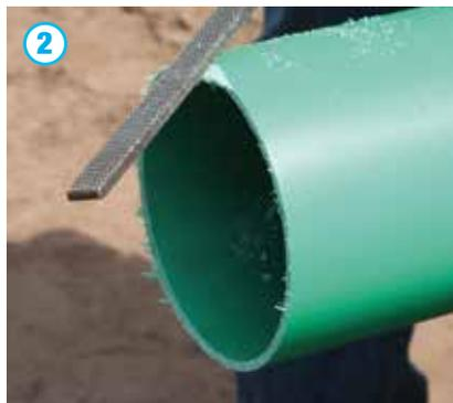
Заусеницы и неровности необходимо удалить с помощью подходящего инструмента, например, скребка. Кроме того, необходимо тщательно восстановить фаску по всему периметру сечения, например, с помощью грубого напильника.
