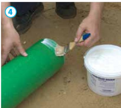
Необходимо проверить правильное расположение уплотнительного элемента в раструбе. Отмеченный участок гладкого конца трубы должен быть равномерно по окружности смазан, а после вставлен в раструб до упора.
